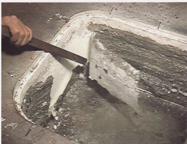
コーティングした時の“おぼけ”の除去状況(新炉)(補修炉)ピック使用
